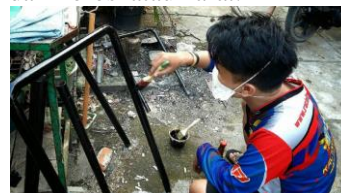
Gambar 25 Pengecatan Pada Pipa Pendorong, Pipa Suport, Pipa Tongkat
