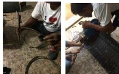
**Gambar 12.** Pemotongan, pembentukan dan pengelasan besi *wiremesh*
