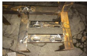
Gambar 21 Proses penyambungan motor support pada rangka
