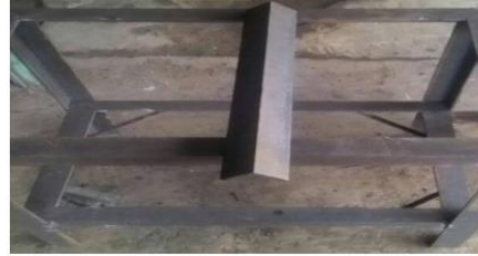
Gambar 19 Proses penyambungan sisi alas bawah pada tiang
