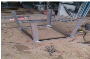
Gambar 18 Penyambungan sisi alas atas pada tiang
