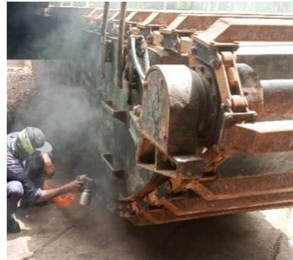
Gambar 8. Pengecatan ponton
