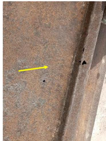
Gambar 6. Kebocoran pada ponton
