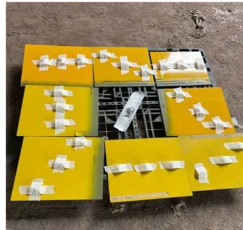
Gambar 4 Pemasangan Dolly guna persiapan pull off test pada permukaan cat
