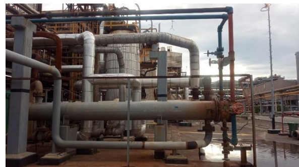
Gambar 6. Observasi awal pada unit Heat Exchanger
