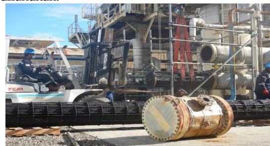
Gambar 7. Pemeriksaan shell and tube (heat exchanger) pada unit yang telah disambly
