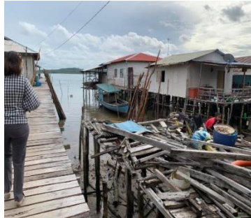
Gambar. 3 Bangunan yang tidak terpakai dan terbengkalai lapuk
