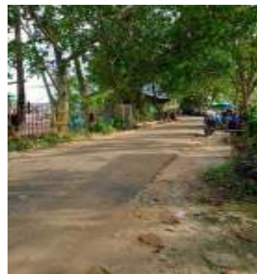
Gambar Kondisi Jalan
