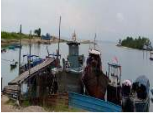
Gambar Kondisi pelabuhan
