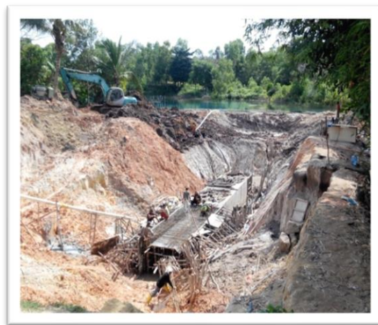
Gambar 5. Pembangunan Penyatuan Waduk Dang Merdu ke Waduk Utama Waduk Sei Bati
