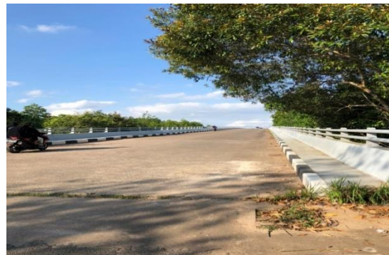
Gambar 5. Jembatan III Dompok dengan panjang + 300 meter
