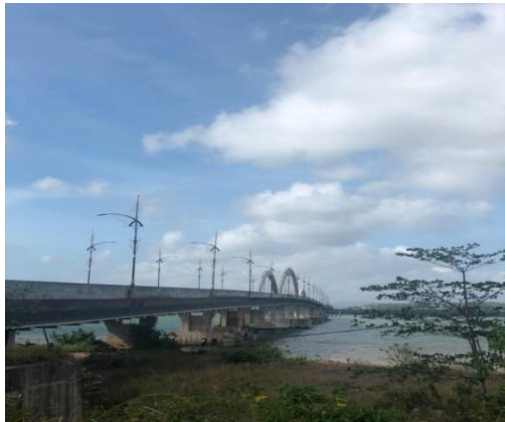
Gambar 3. Jembatan I dengan panjang 1.450 m
