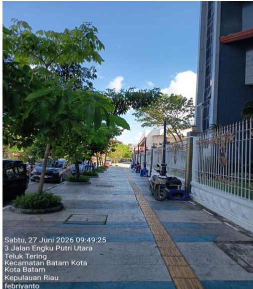
Gambar 1. Kondisi trotoar Jalan Engku Putri Utara — dokumentasi lapangan, 27 Juni 2026
