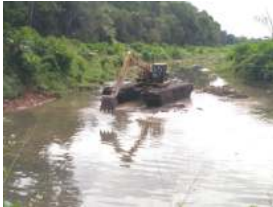
Gambar 1. Excavator Amphibious sedang melakukan pendalaman alur sungai
