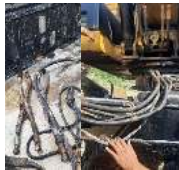
Gambar 9. Hose yang rusak pada excavator amphibious
