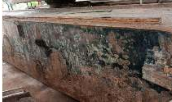
Gambar 3. Ponton yang berkarat yang disebabkan korosi
