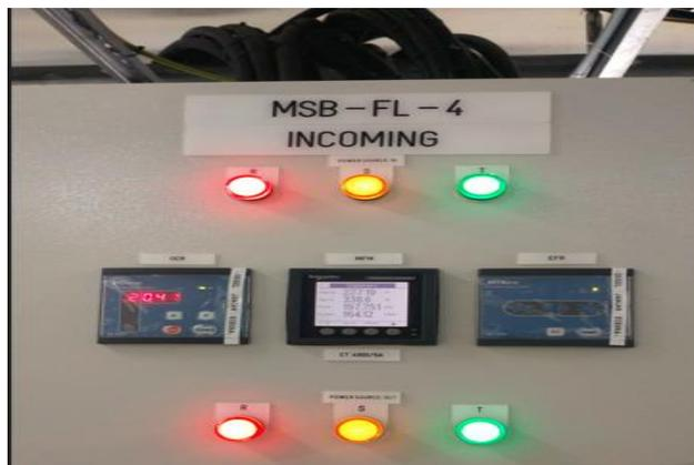
Gambar 5. Sistem proteksi terpasang di panel kubikel
