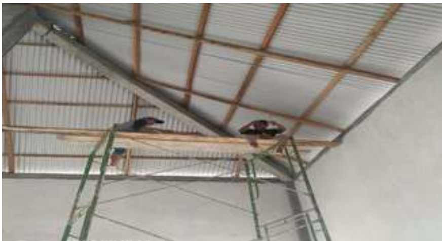
Gambar 5. Pemasangan Instalasi Mesjid Al-Ikhlax
