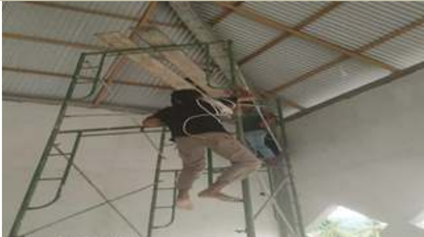
Gambar 6. Pemasangan Instalasi Masjid Al-Ihklas
