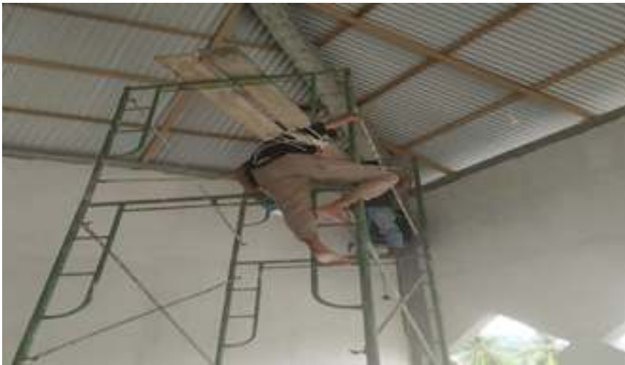
Gambar 4. Pemasangan Instalasi Mesjid Al-Ikhlax
