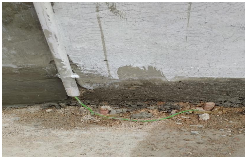
Gambar 4. Pemasangan Instalasi groundingi Mushola Al-Muttaqiin
