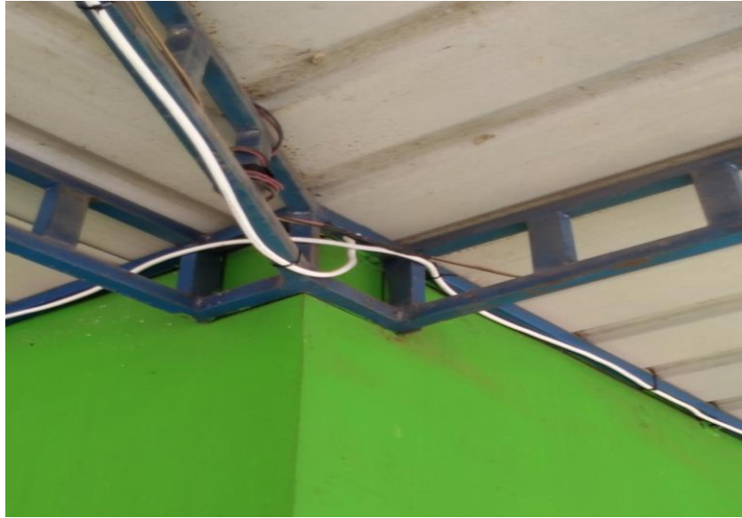
Gambar 5. Pemasangan Instalasi Mushola Al-Muttaqin
