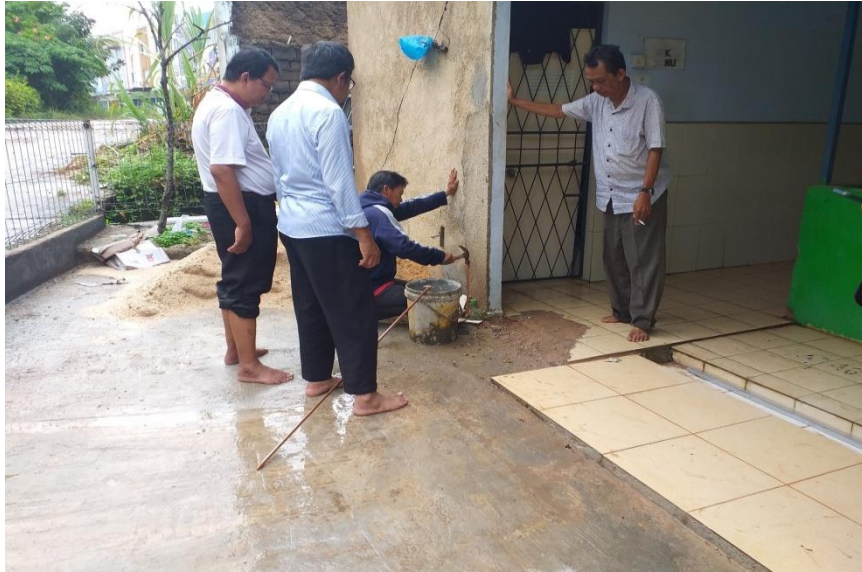
Gambar 3. Pemasangan Grounding Mushola Al-Muttaqiin
